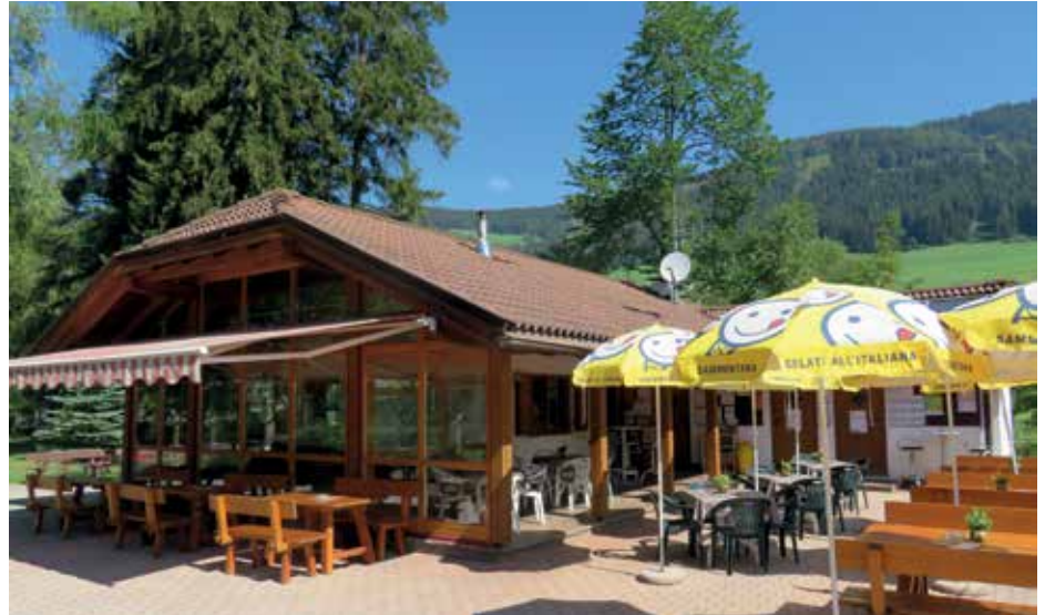
Das Tennischalet in der Parkanlage steht vor der Sanierung
